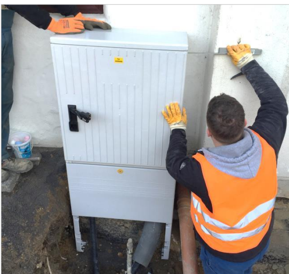
Schrank ausrichten
