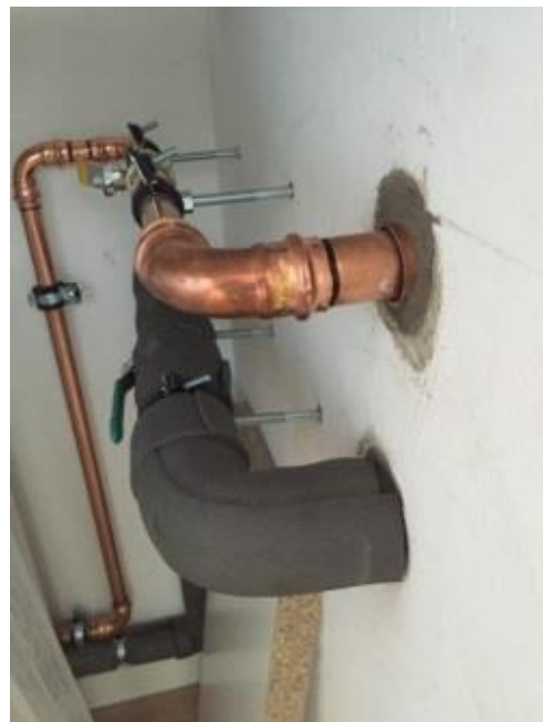
Inneninstallation abschließen
