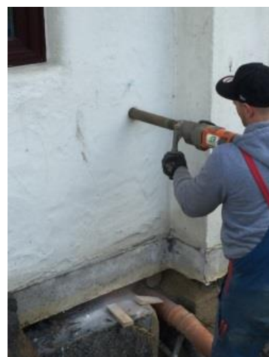
Kernbohrung ins Haus setzen
