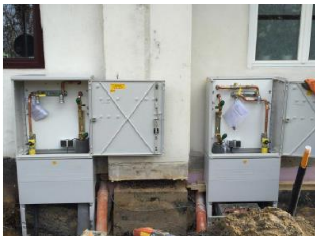
Prüfung des Anschlusses
