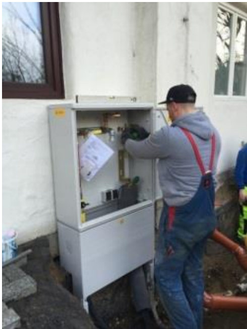
Rohrverbindung ins Haus legen
